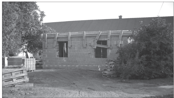
Nagy örömeinkre elkezdődött az egészségház korszerűsítése, bővítése. A beruházásról, valamint a rendelésekről lapunk 3. oldalán olvashatnak
